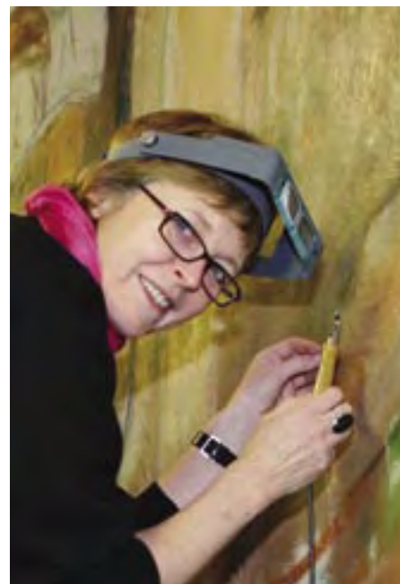
Mille Stein viser korleis syntetisk harpiks vert aktivert med varmeskei, og den lause målinga vert festa til underlaget. (Foto: Johanne Landsverk)
