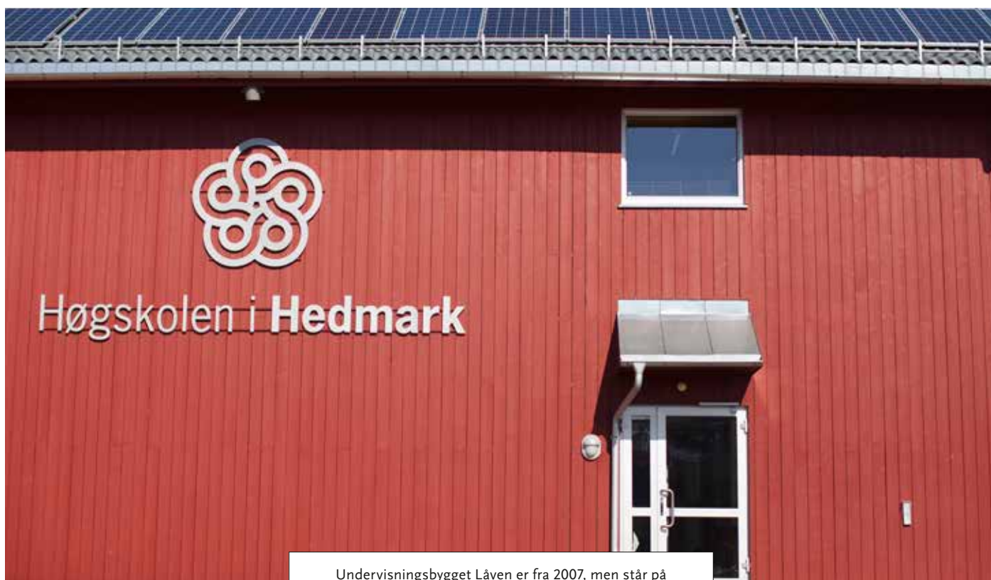
Undervisningsbygget Låven er fra 2007, men står på gammellåvens grunn og vitner om tidligere tiders gårdsbruk.
